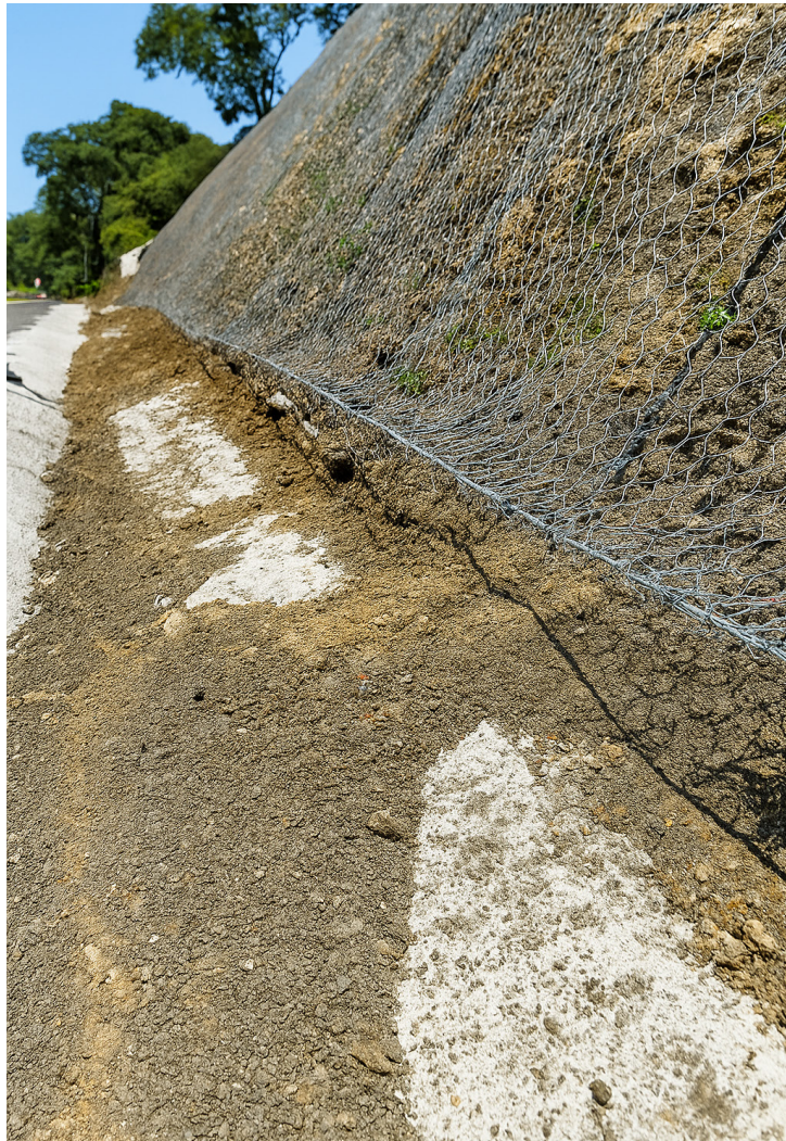
Fotografía 2.1. Revestimiento de talud mediante guías.
