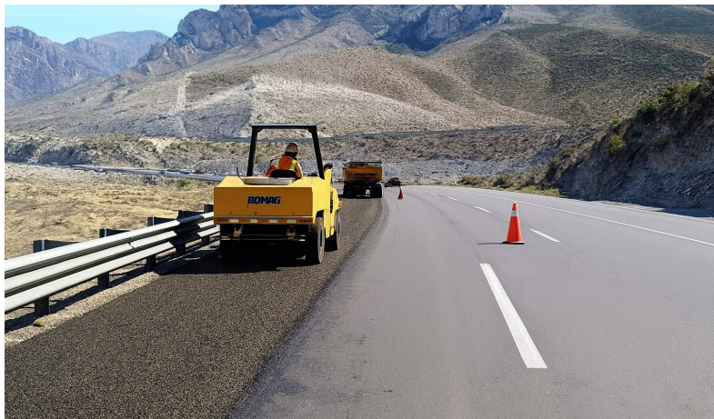
Fotografía 3.1. Capa de riego de sello en una carretera en México
